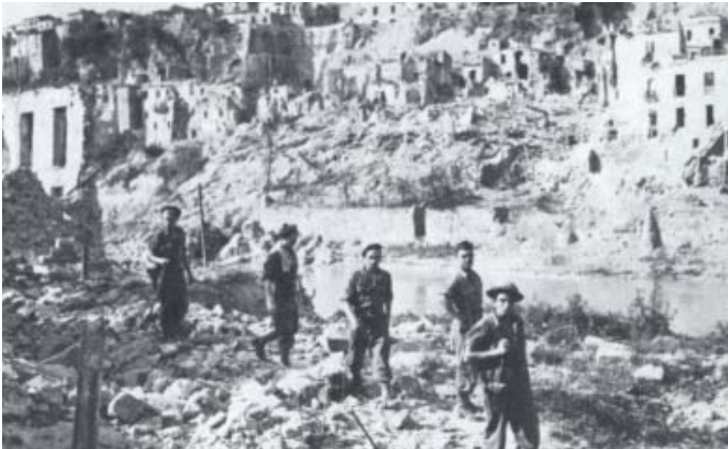
Elément de la 1 re DFL progressant dans les ruines de Pontecorvo (Italie).
