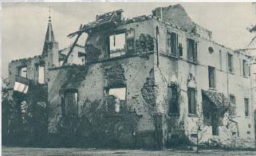
La mairie d'Obenheim détruite par les bombardements allemands.
